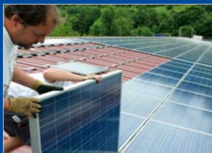
Das HABDANK TR-Montagesystem für Trapezblech-dächer ist schnell und einfach zu montieren.
