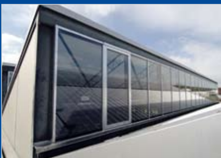
Die neue Isolier-Verglasung bringt mehr Licht in die Produktion und spart wertvolle Heizenergie.
