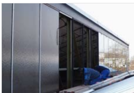
Der Austausch der alten Verglasung gegen das Isolierglas-Lichtband von Habdank erfolgt Hand in Hand.
